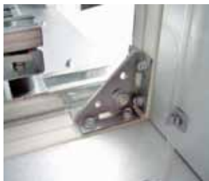
→ соединение секций
