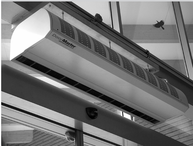
Рис. 3 – монтаж над входными дверями
