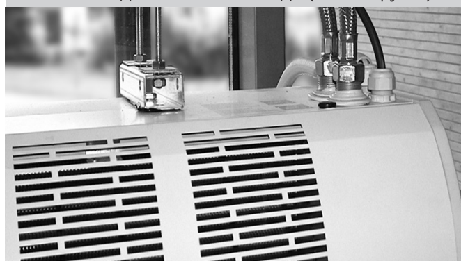
Рис. 13 – подключение отоп. воды (гибкие трубки)
