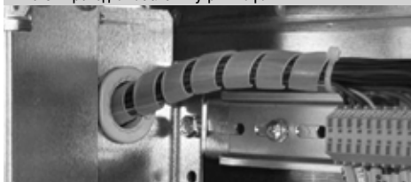
Рис. 5 – проводка кабелей внутри шкафа
