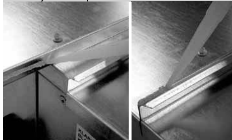
Рис. 10 – уплотнение крышек
