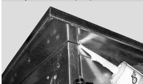
Рис. 13 – уплотнение нижней стороны крышки
