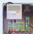
Плата управления, силовой трансформатор, клеммы подключения
