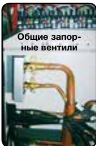
В наружных блоках (модели 1:4 и 1:5) помимо выходных портов для каждого внутреннего блока есть два общих запорных вентиля, через которые удобно осуществлять вакуумирование и дозаправку системы, а также проводить измерения высокого и низкого давления в системе.
