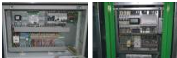
ЩА (щит автоматики, на базе контроллера Carel)
